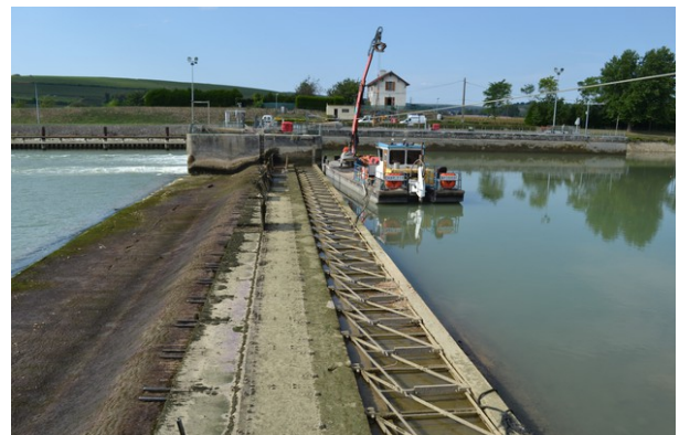
Barrage de Charly-sur-Marne mis à sec
